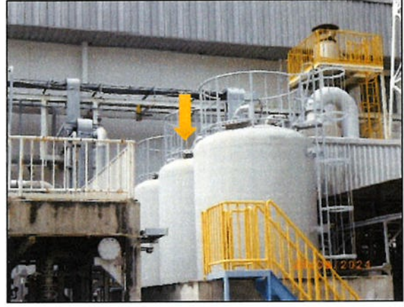
รูปที่ 7 บ่อพักน้ำทิ้งจากเนินบริเวณ ระบบหอดูดซึม
