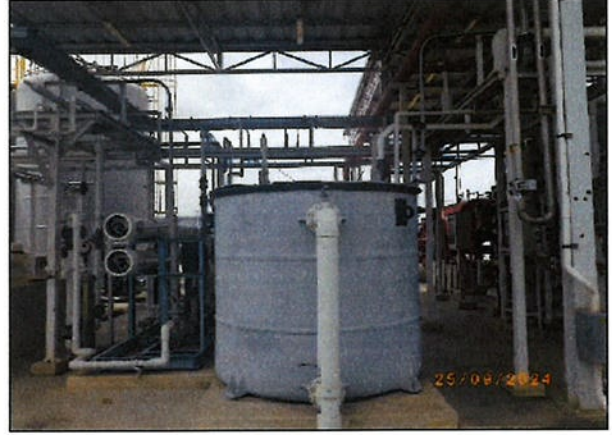
รูปที่ 12 ถังพักน้ำทิ้งจากระบบผลิตน้ำ RO (RO Brine)
