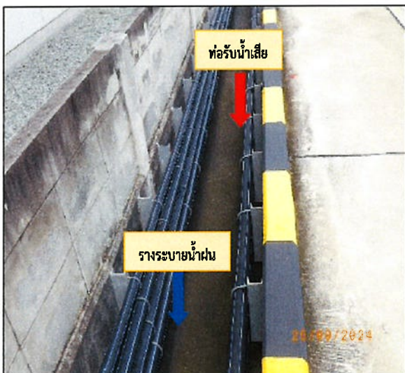
รูปที่ 26 ระบบระบายน้ำที่แยกออกจากรางระบายน้ำฝน
