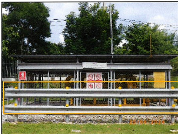
รูปที่ 44 สถานีควบคุมก๊าซและแนวท่อก๊าซ
