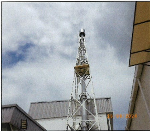
รูปที่ 3 ปล่องเตาอบละลาย (Solution Treatment Furnace)
