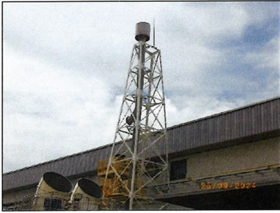
รูปที่ 1 ปล่องระบายจากระบบهودดูดซึม (Exhaust Gas Treatment System)
