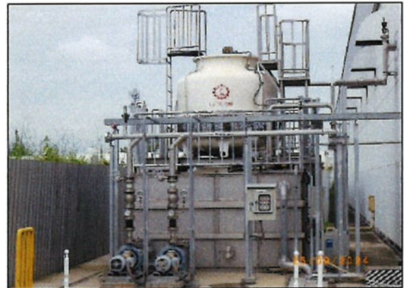
รูปที่ 16 ถังพักน้ำหมุนเวียนจาก ระบบหล่อเย็นของหน่วยยัดและม้วน (A8#2)
