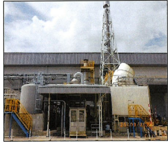
ภาพที่ 4 ระบบบำบัดมลพิษอากาศ แบบระบบهودดูดซึม (Spray Tower)
