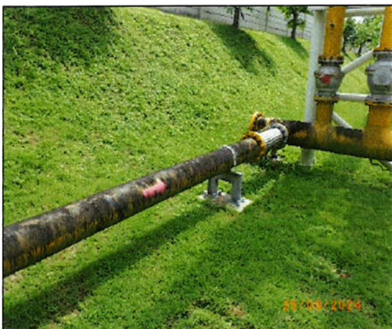
รูปที่ 45 ระบบท่อ Bypass และระบบวาล์วสำรอง
