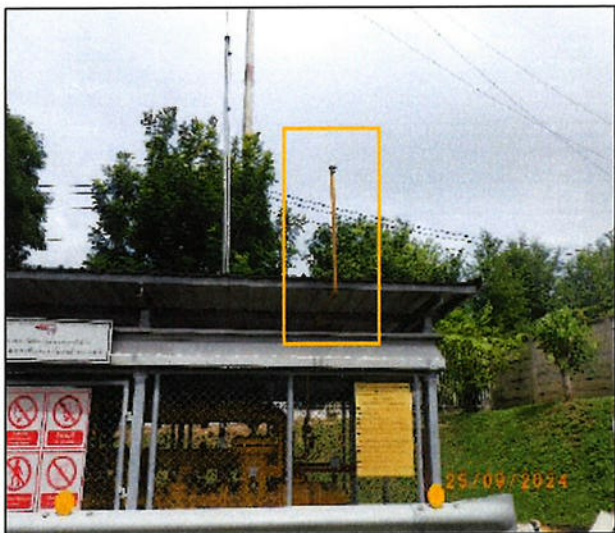
รูปที่ 46 ปล่องระบายก๊าซ (Blow Down Stack)
