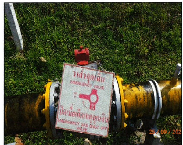
รูปที่ 45 ระบบท่อ Bypass และระบบวาล์วสำรอง
